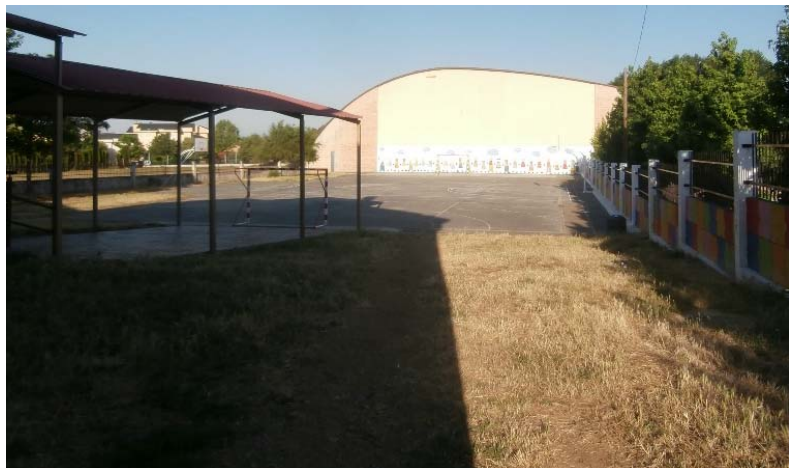
Vista de cubierta de patio existente a mantener y pista a cubrir
